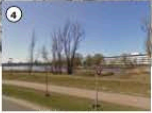
4 Groen oostzijde Plas Lage Weide Nu: voetpad ontbreekt. Wens: voetpad aangelegd langs de Plas.
